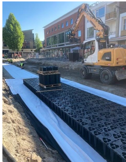
Figuur 5: Aanleg ondergrondse voorzieningen Markt/Brinkstraat
