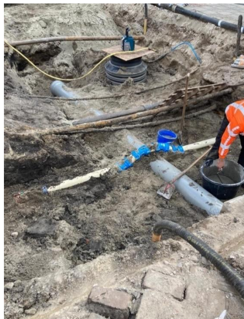
Figuur 7: Uitvoering rioleringswerkzaamheden
