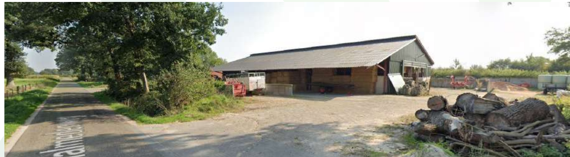
Figuur 2 Huidige situatie vanaf de Dalmedenweg september 2020 (Bron: Streetview Google Maps)
